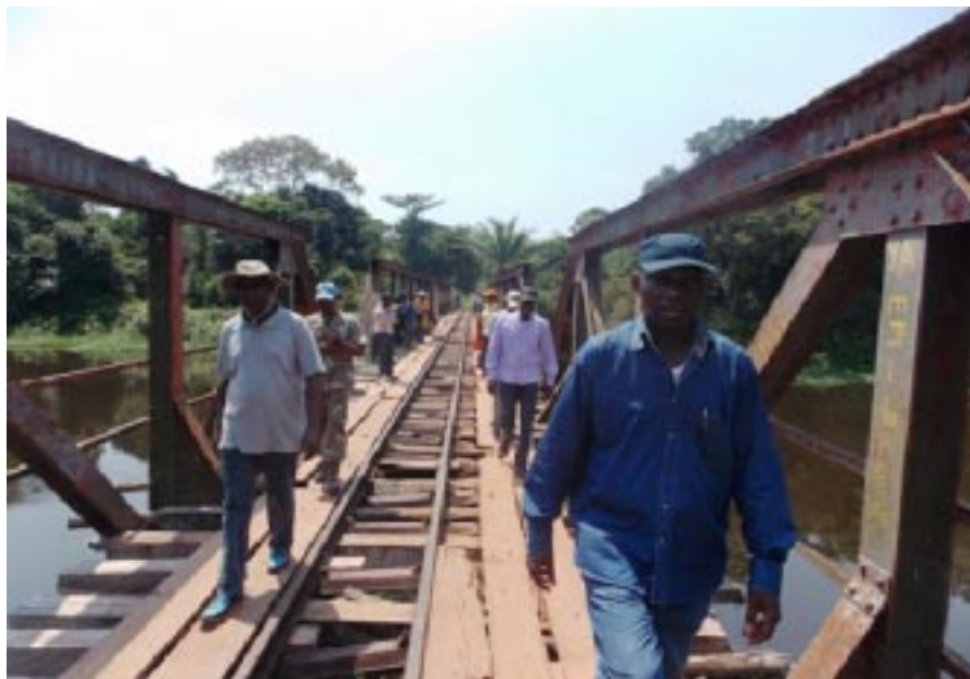
Visite du pont mixte Nguma sur la route d'Aketi, à 12 km de Dulia
