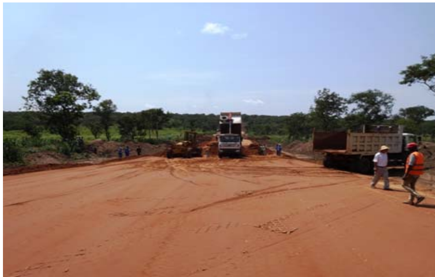
Travaux de préparation de la plateforme
